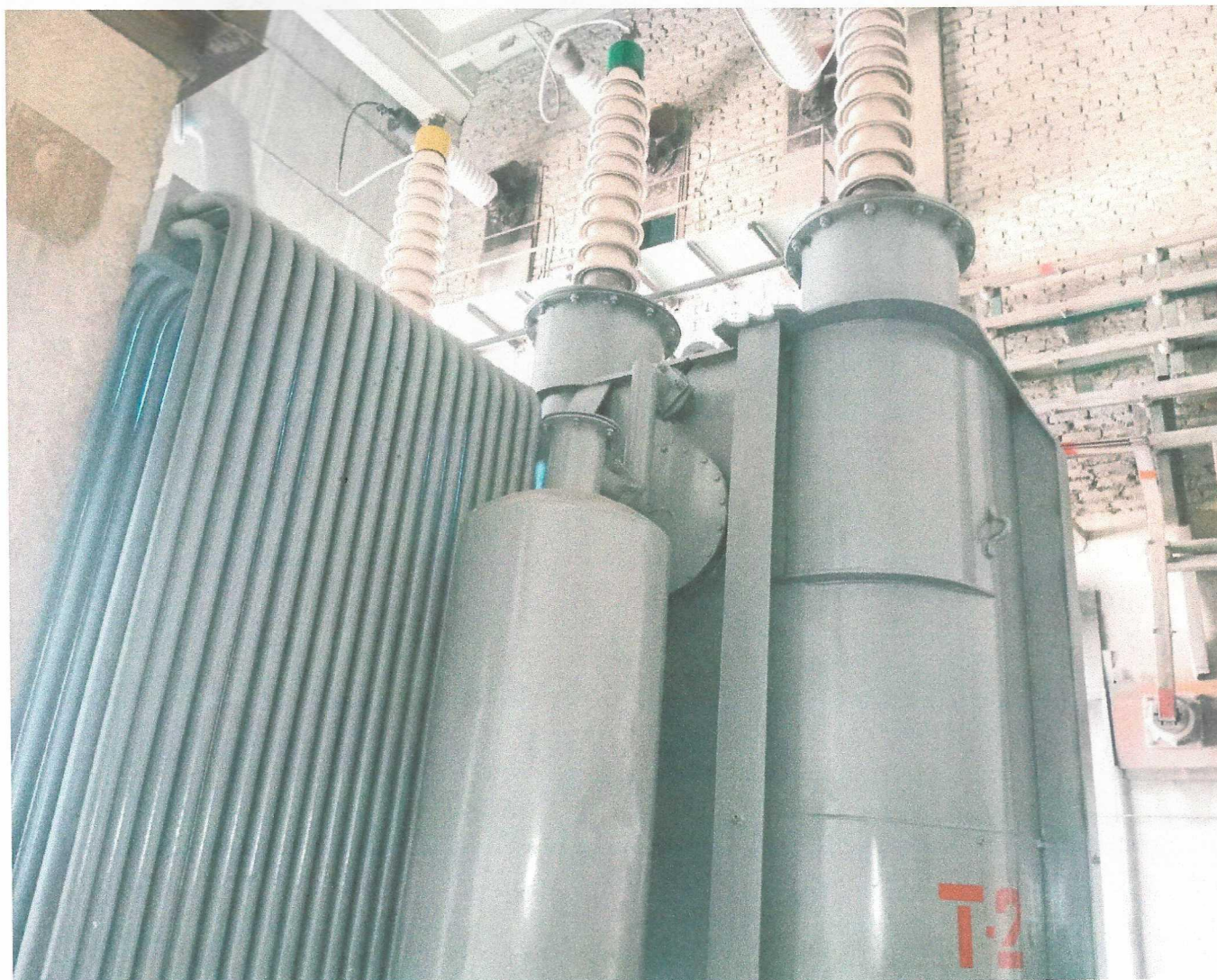
После ремонта: Покраска трансформатора
